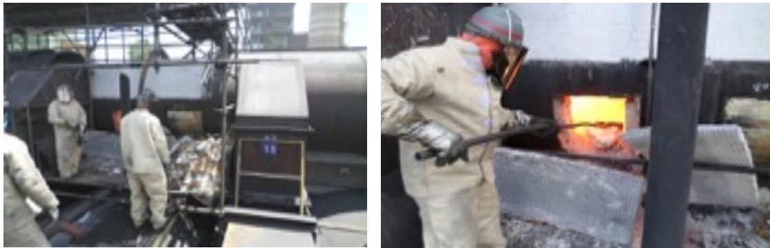
Figura 9- Conclusão da montagem e ancoragem com tela.
