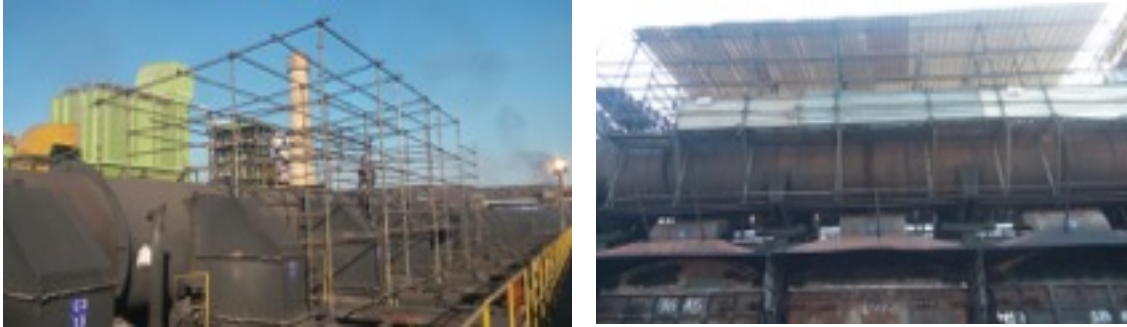
Figura 4: Início da montagem do andaime para o reparo e Andaimos Prontos.
