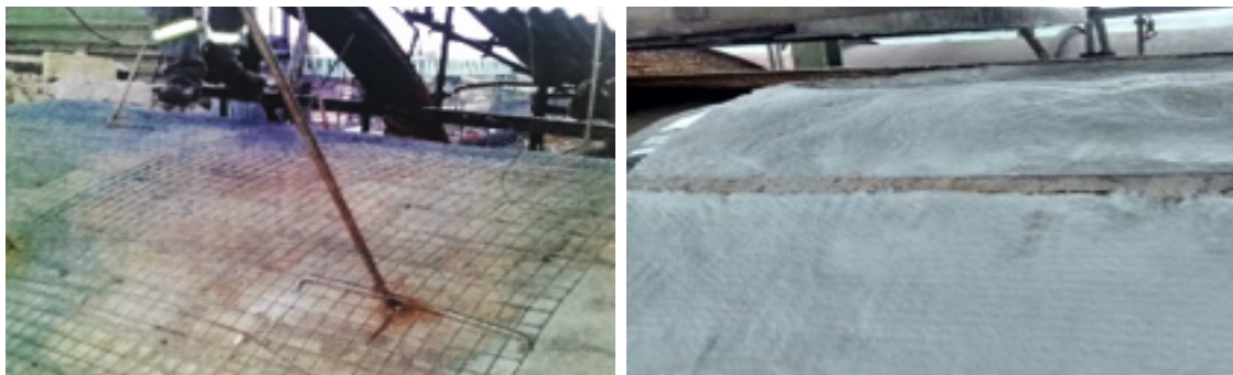
Figura 10-Preparação com bisel para fechar o reparo e Início do processo de Soldagem.
