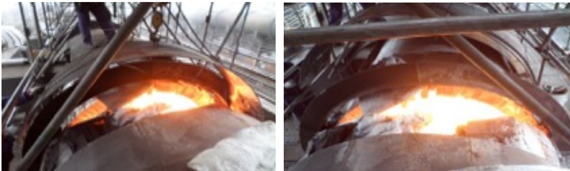
Figura 5 - Remoção da chapa para colocação da caixa fria.
