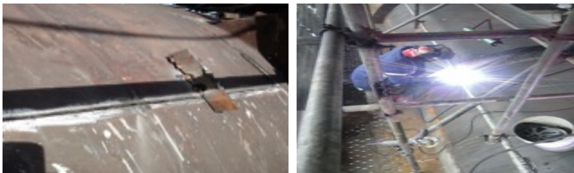
Figura 11 - Limpeza interna, para melhorar o fluxo de vapor e remoção do refratário.
