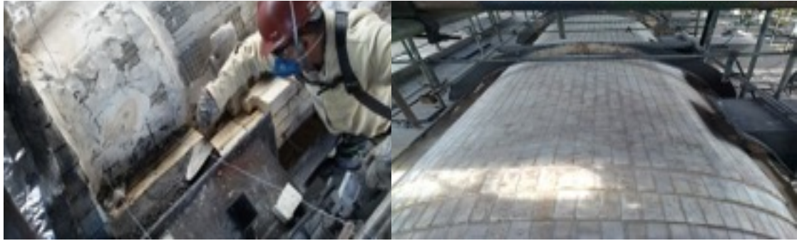
Fotos 8- Iniciando a ancoragem para fazer a montagem refrataria.
