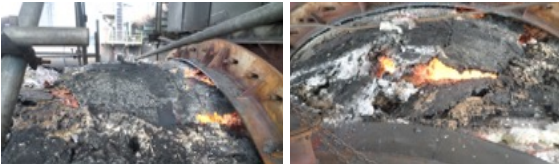
Figura 6 - Retirada do refratário danificado.
