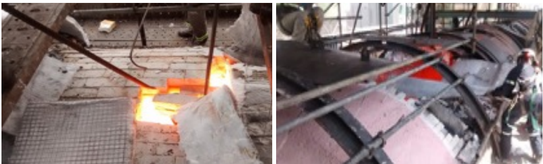
Figura 7- Limpeza e colocação da caixa fria.
